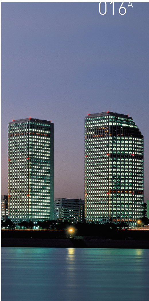
016A LG트윈타워 위치: 서울시 영등포구 여의도동 공사내용: - 연면적 157,835㎡ - 지상34층/지하3층 공사기간: 1983.06 - 1987.06
