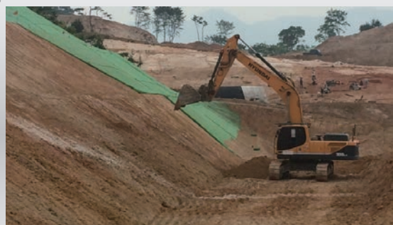
[광주외곽순환고속도로 2공구 사면조성공사]
