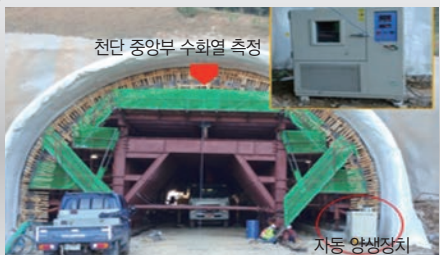
[서울문산 3공구, 콘크리트 라이닝 관리]
