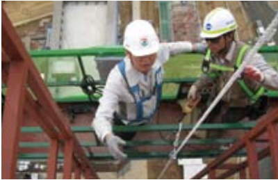
외형 조형물 설치용 콘도라 점검
